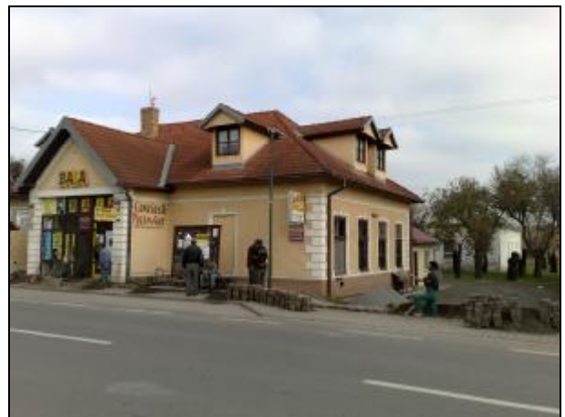
Práce na výstavbe káblového distribučného systému v obci
